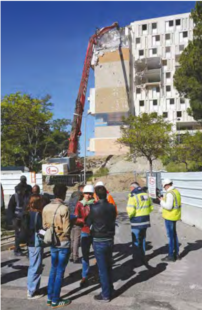
Les bâtiments K et M qui constituent un seul ouvrage ont été grignotés en partant du haut.
